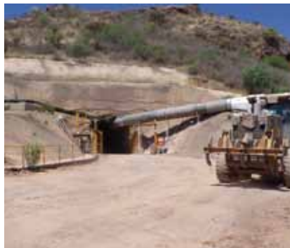
建設中のロス・ガトス亜鉛鉱山
