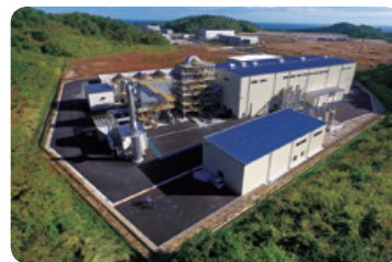
溶融・再資源化処理施設
