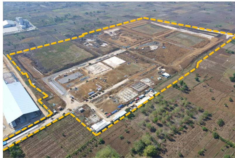
第2処分場（建設中）
