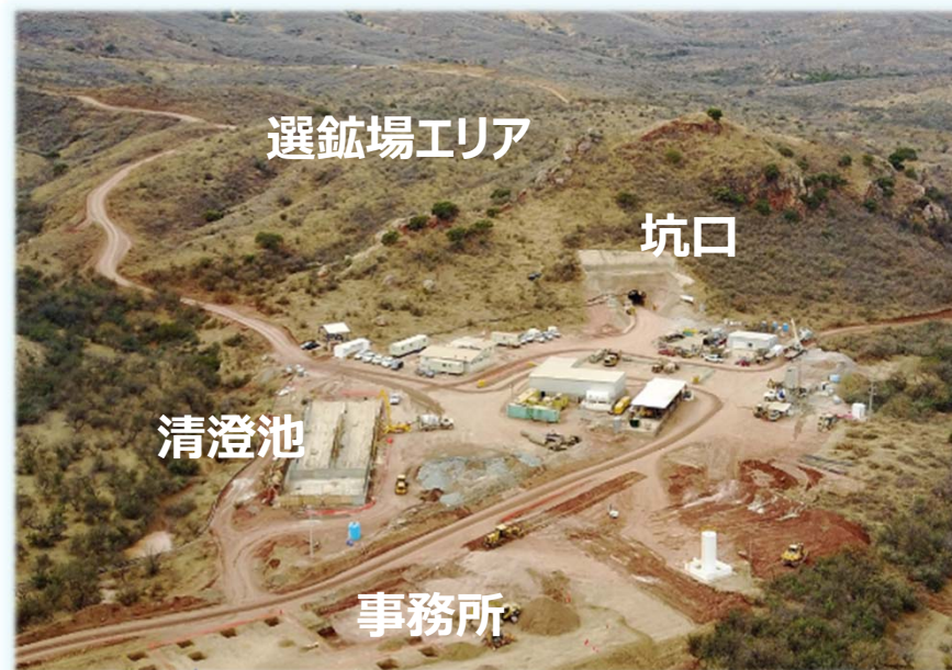
ロス・ガトスプロジェクト 建設の状況
