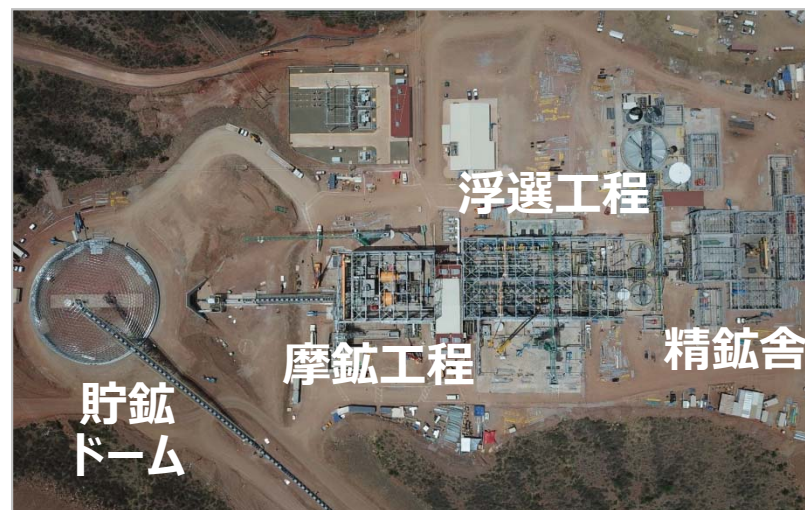
建設中の選鉱場
