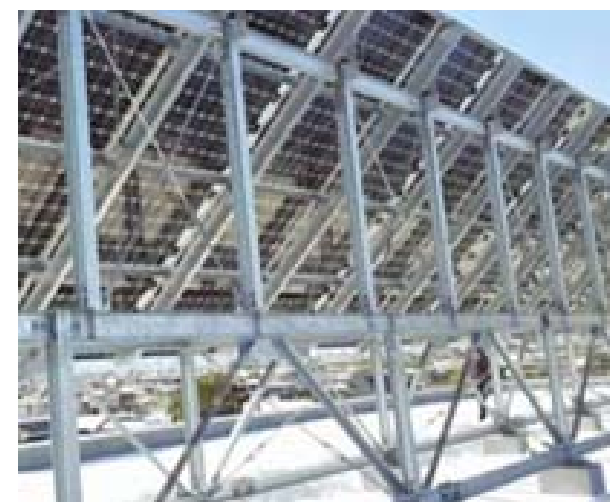
次世代型パネルの例 (パネル両面で発電)
