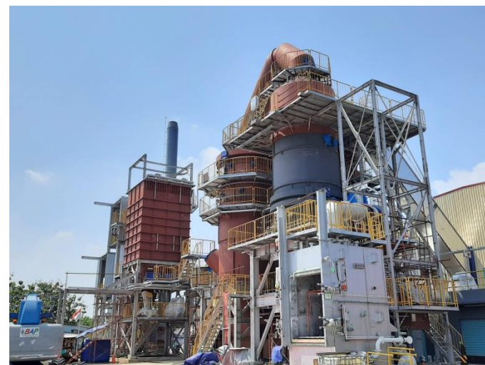
インドネシアで建設中の焼却炉
