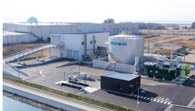
バイオガス発電施設
