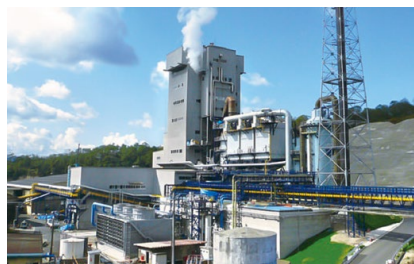
2007年に小坂製錬に建設したリサイクル専用炉
