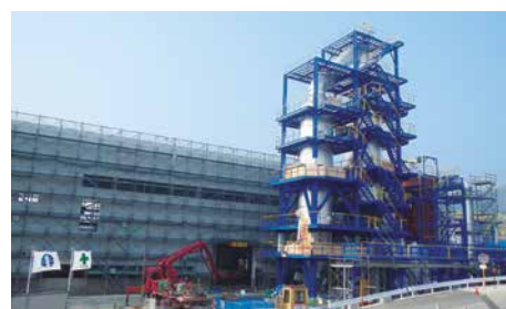
秋田で建設中の低濃度PCB処理施設
