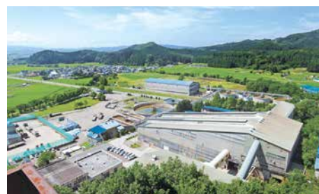
秋田の土壌浄化施設
