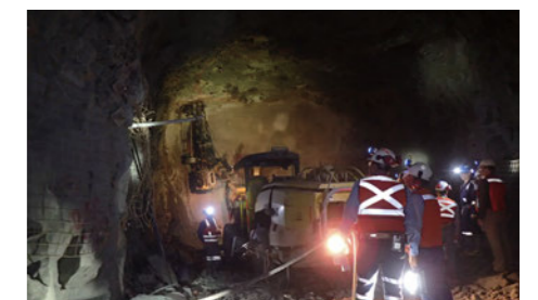
ロス・ガトス プロジェクトの坑道掘進
