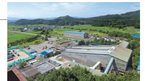
エコシステム花岡の土壌浄化施設
