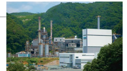
エコシステム山陽の廃棄物処理施設
